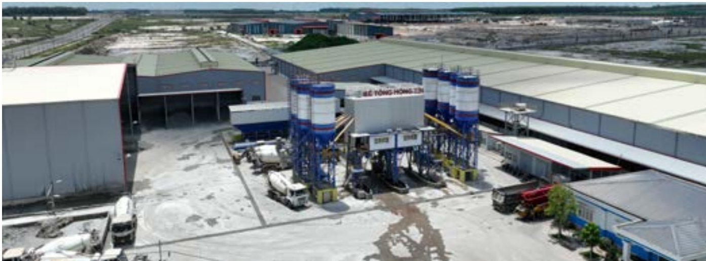
Nhà Máy Bê tông Hồng Tín – Bình Phước
