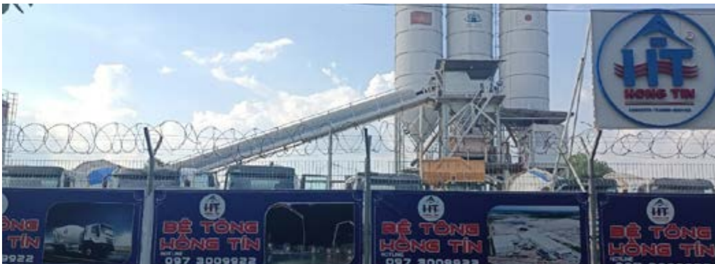
Nhà máy Bê tông Hồng Tín – Trạm Phú Mỹ
