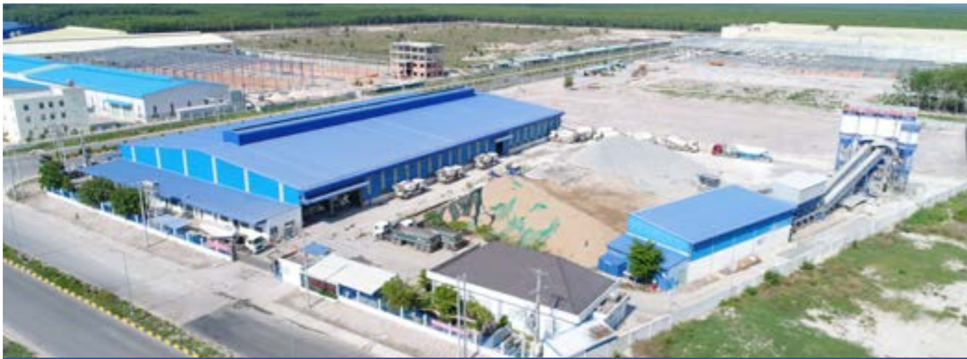
Nhà máy Bê tông Hồng Tín - Bình Dương
