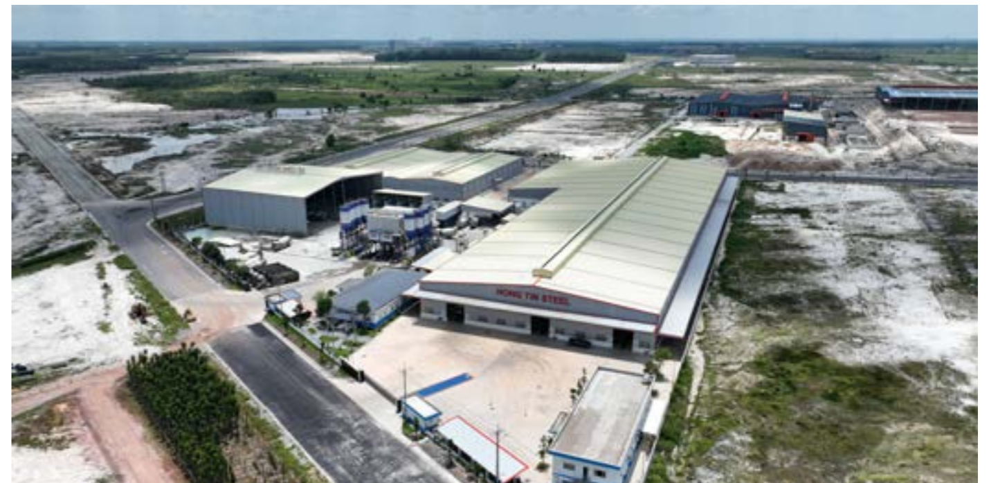
Nhà máy kết cấu thép Hồng Tín - Bình Phước
